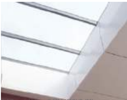
Habillage intérieur © ETS LAFFOND (25)
