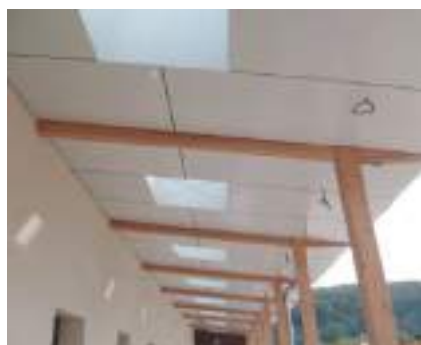
Habillage de plafonds
