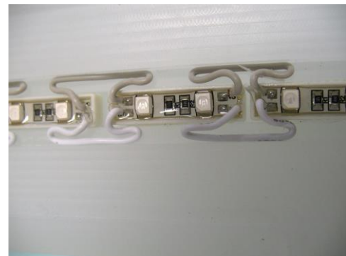
Repli des câbles sur la défonce.
