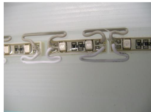
Repli des câbles sur la défonce.
