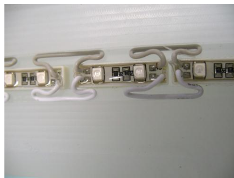
Repli des câbles sur la défonce.
