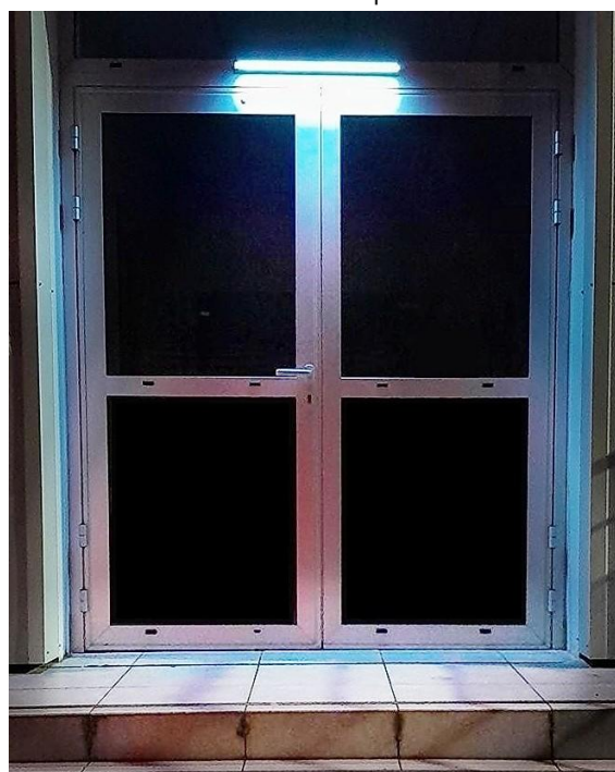
Mise en situation avec une rampe de 60cm rasante
